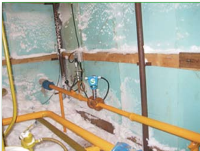
Первый узел учета газа, установленный на объекте ОАО «Тамбейнефтегаз»
