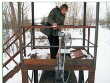
6-я операция. Электрическое подключение расходомера
