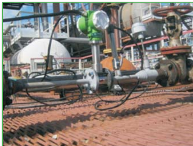
Узел учета ПНГ на базе ЭМИС-ВИХРЬ-200
