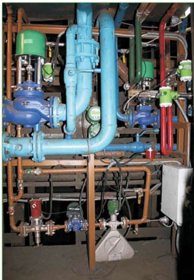
Узел учета на установке для подачи кислорода и мазута в печь
