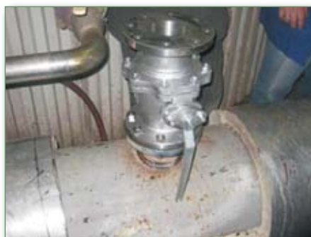
Установленный на фланцевый патрубок шаровой кран
