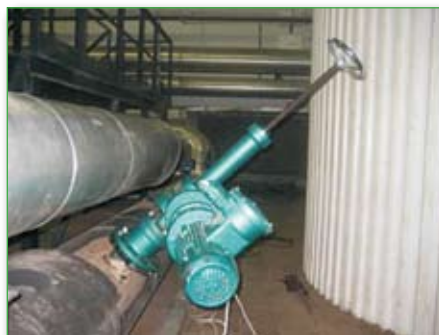
Специальное оборудование для «горячей врезки»
