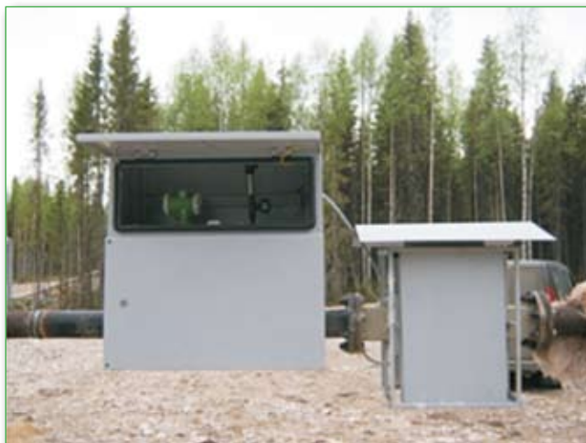
Узел учета пара с автономным источником питания
