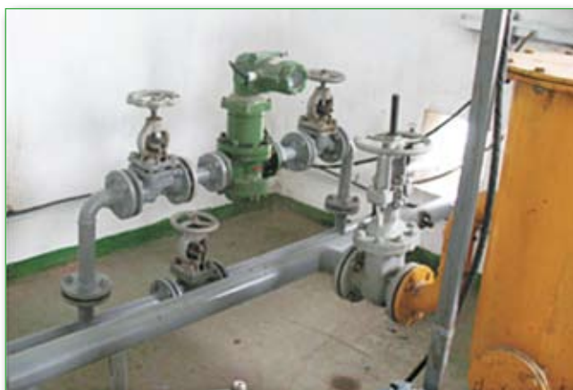
Учет расхода нефти на установке по переработке нефти осуществляется с помощью расходомера ЭМИС-ДИО 230
