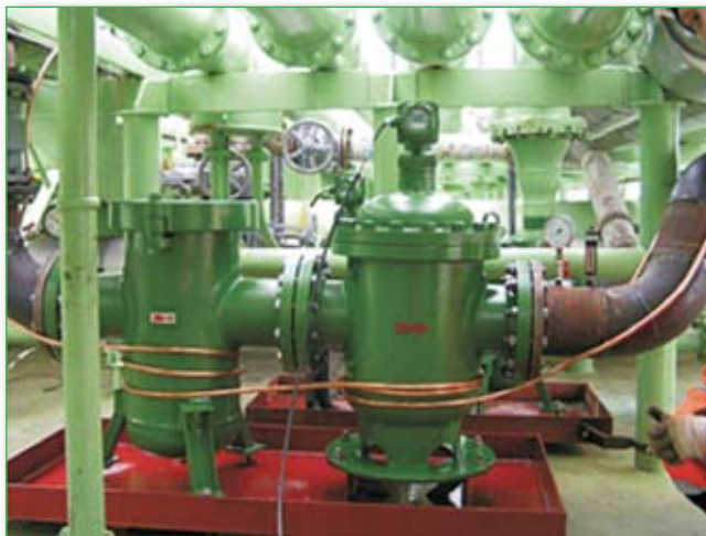
Установленный расходомер ЭМИС-ДИО 230 и фильтр жидкости ЭМИС-ВЕКТА на трубопроводе ДУ=200 мм
