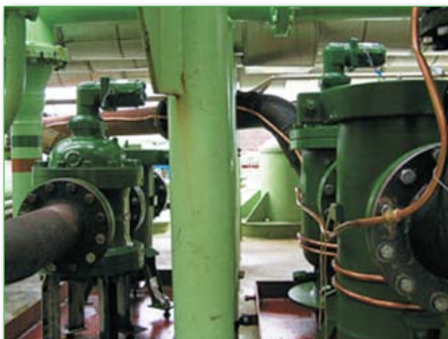
Установленный расходомер ЭМИС-ДИО 230 и фильтр жидкости серии ЭМИС-ВЕКТА на трубопроводе ДУ=150 мм
