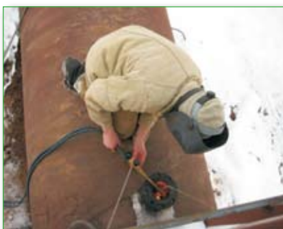
2-я операция. Остановка потока и вырезка отверстия в трубопроводе
