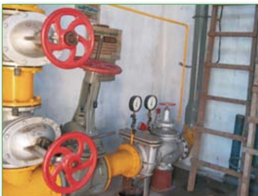
Теперь фильтр газа не нужен, так как используется вихревой расходомер
