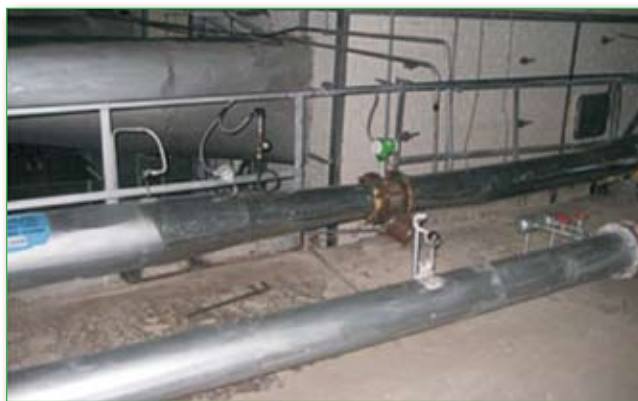
Узел учета пара на базе расходомера ЭМИС-ВИХРЬ 200 обеспечивает более высокую точность измерений и не требует обслуживания в сравнении с узлом, основанным на методе перепада давления, расположенным на соседнем трубопроводе.
