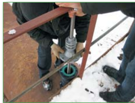
4-я операция. Установка расходомера на закрытый шаровый кран
