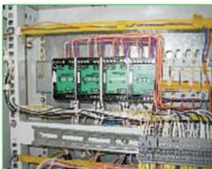
Питание расходомеров обеспечено с помощью блоков ЭМИС-БРИЗ 10, установленных в диспетчерской. Блоки ЭМИС-БРИЗ 10 используются также для преобразования частотного сигнала в аналоговый 4–20 мА с целью интеграции датчиков расхода в АСУТП
