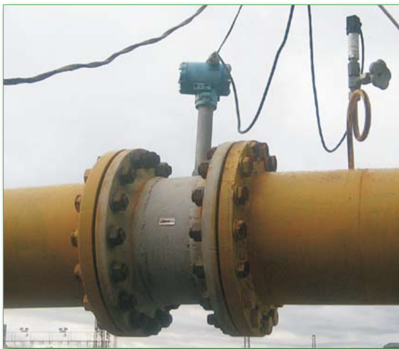
Вихревой расходомер ЭМИС-ВИХРЬ 200 диаметром 300 мм в одном из узлов учета природного газа
