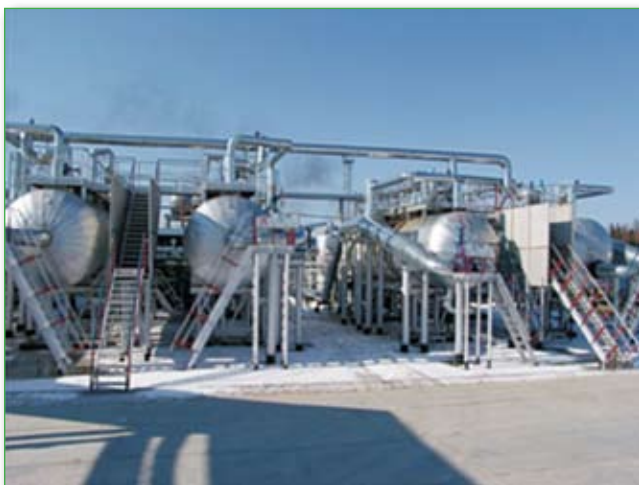
На этой нефтебазе установлены расходомеры «ЭМИС»
