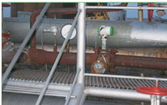
Закрепленная технологическая вставка делает обслуживание прибора максимально удобным и позволяет сократить время простоя трубопровода
