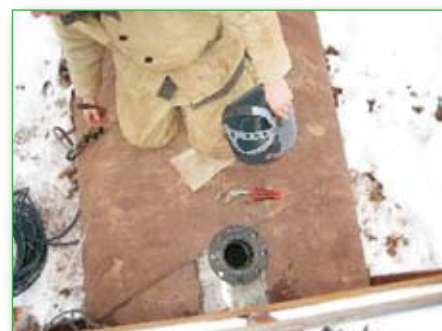
Отверстие вырезано, теперь можно устанавливать шаровый кран
