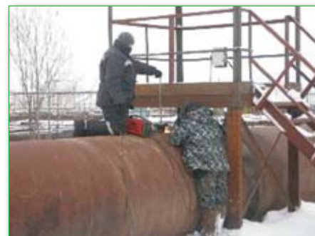
2-я операция. Остановка потока и вырезка отверстия в трубопроводе
