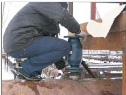
3-я операция. Установка закрытого шарового крана и возобновление потока в трубопроводе
