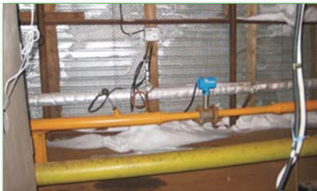
Второй узел учета газа, установленный на объекте ОАО «Тамбейнефтегаз»
