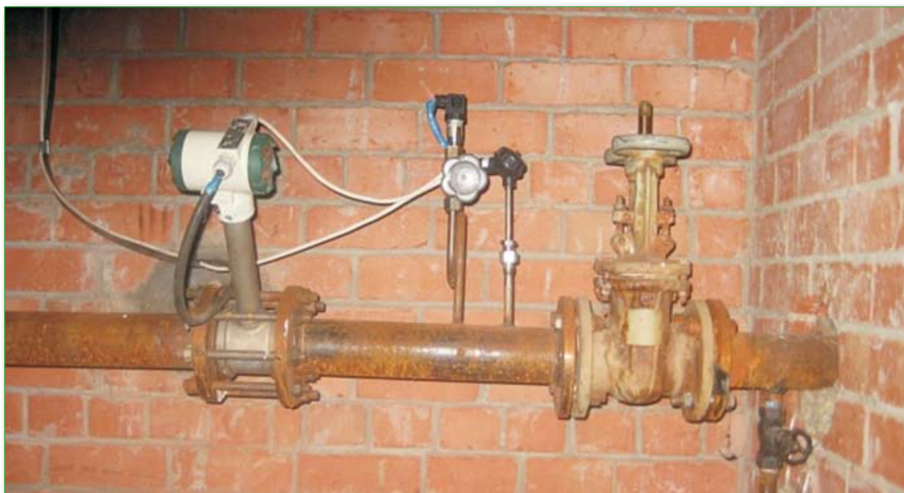
Приборы учета тепла: вихревой расходомер ЭМИС-ВИХРЬ 200, датчики АИР и ТС, установленные на ООО «Вахрушевский механический завод»
