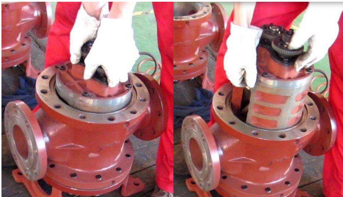
Рисунок 2.6 – Демонтаж измерительной камеры
