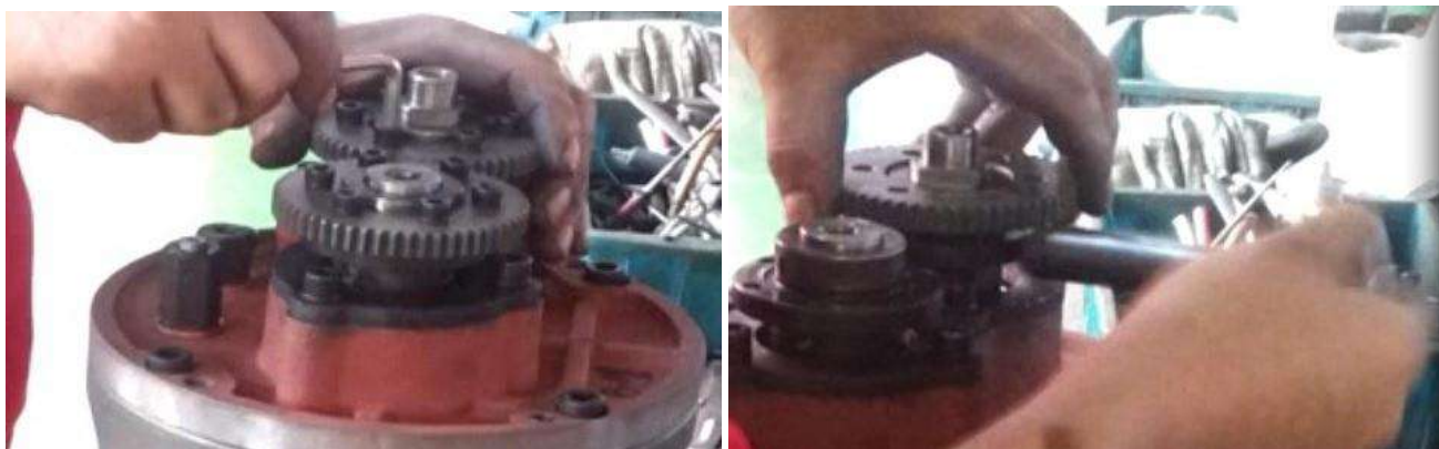
Рисунок 2.8 Снятие шестеренок
