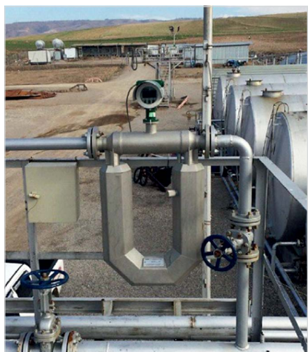
Рис. 2 б — Массовый расходомер ЭМИС-МАСС 260 Ду 50 в узле налива нефтепродуктов
